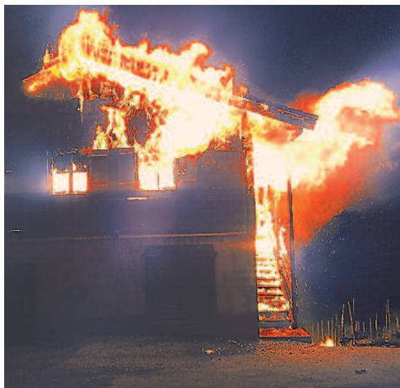
Zerstört. Das Gebäude in Molignon brannte nieder.
